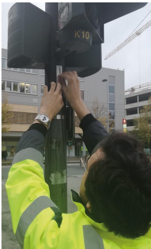
Monteur bei der Anbringung des RFID Aufklebers.
