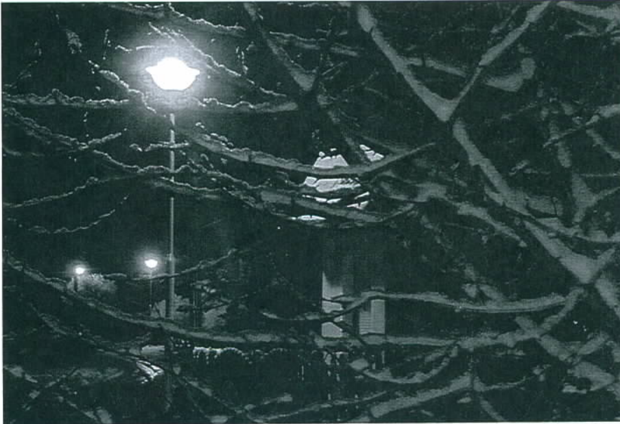
Weit verbreitet sind Natriumdampflampen. Allerdings haben diese gegenüber modernen LED-Leuchten den Nachteil, dass sie nur teilweise und mit deutlichem Stromverlust dimmbar sind. Quelle: Verena N., pixelio.de
